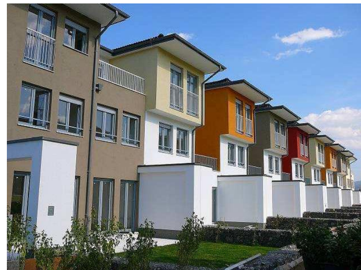
120 000 m 2 топлоизолационни фасади, Резиденшъл Парк София
